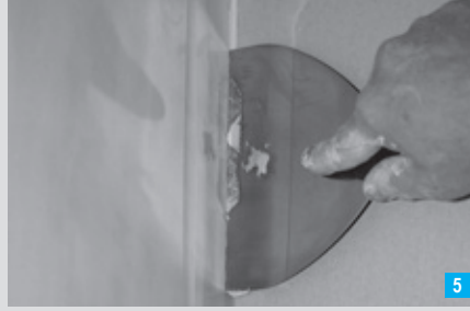
5 Plaka montajı sonrasında dolgu işlemi yapılır.
