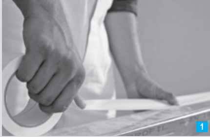
1 Kendinden yapışkanlı Knauf Trenn-Fix DC-/DU profiline yapıştırılır.
