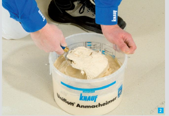
Knauf Uniflott® veya Knauf Fugagips®'in mala ile karıştırılması
