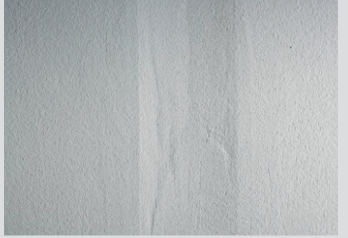
Çok miktarda ışık huzmesinde çökmüş derz dolgusu
