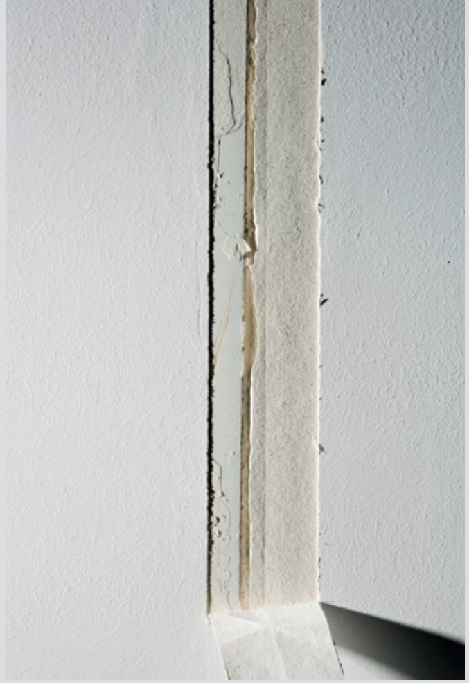
Neden: Küt kenarda (derzin sol tarafı) derz bandının altında yeterli miktarda dolgu malzemesi olmaması
