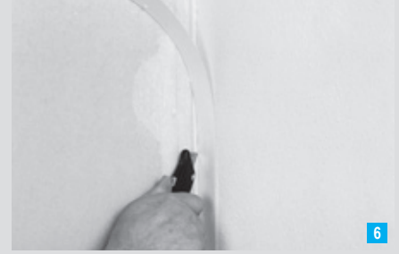
6 Kuruma sonrasında dışarı taşan bantlar kesilir.
