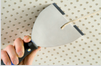
Knauf Uniflott® fazlalığının kuruduktan sonra Knauf Cleaneo® malası ile alınması
