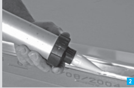
2 İhtiyaç durumunda ses yalıtımı için Knauf Akustik Macun uygulanır.
