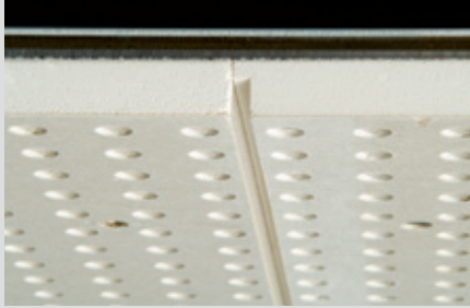
FF kenarı aralıksız olarak yerleştirilir.
