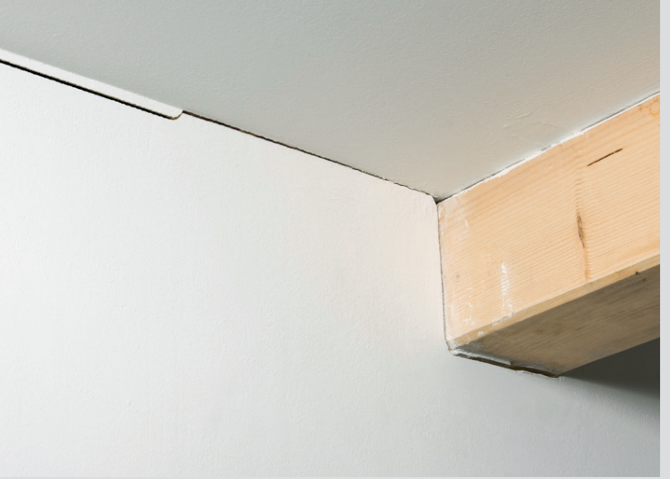
Farklı yapı malzemeleri arasında dilatasyon olmaması nedeniyle oluşan atlamalı çatlak
