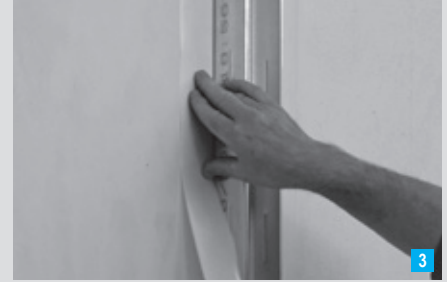
3 Knauf Trenn-Fix, bağlanacak (profil yanına) yapı elemanına yapıştırılır.
