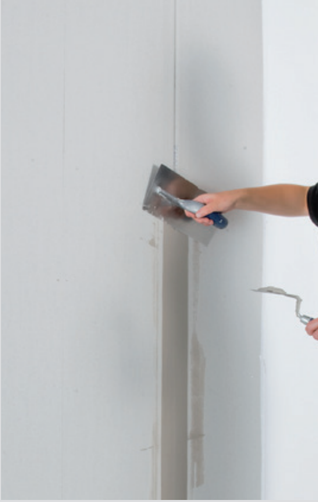
Knauf derz dolgu malzemeleri ile çatlakların güvenilir şekilde sıvanması
