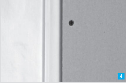
4 Alçıpan®'lar 5 mm boşluk bırakılarak monte edilir.
