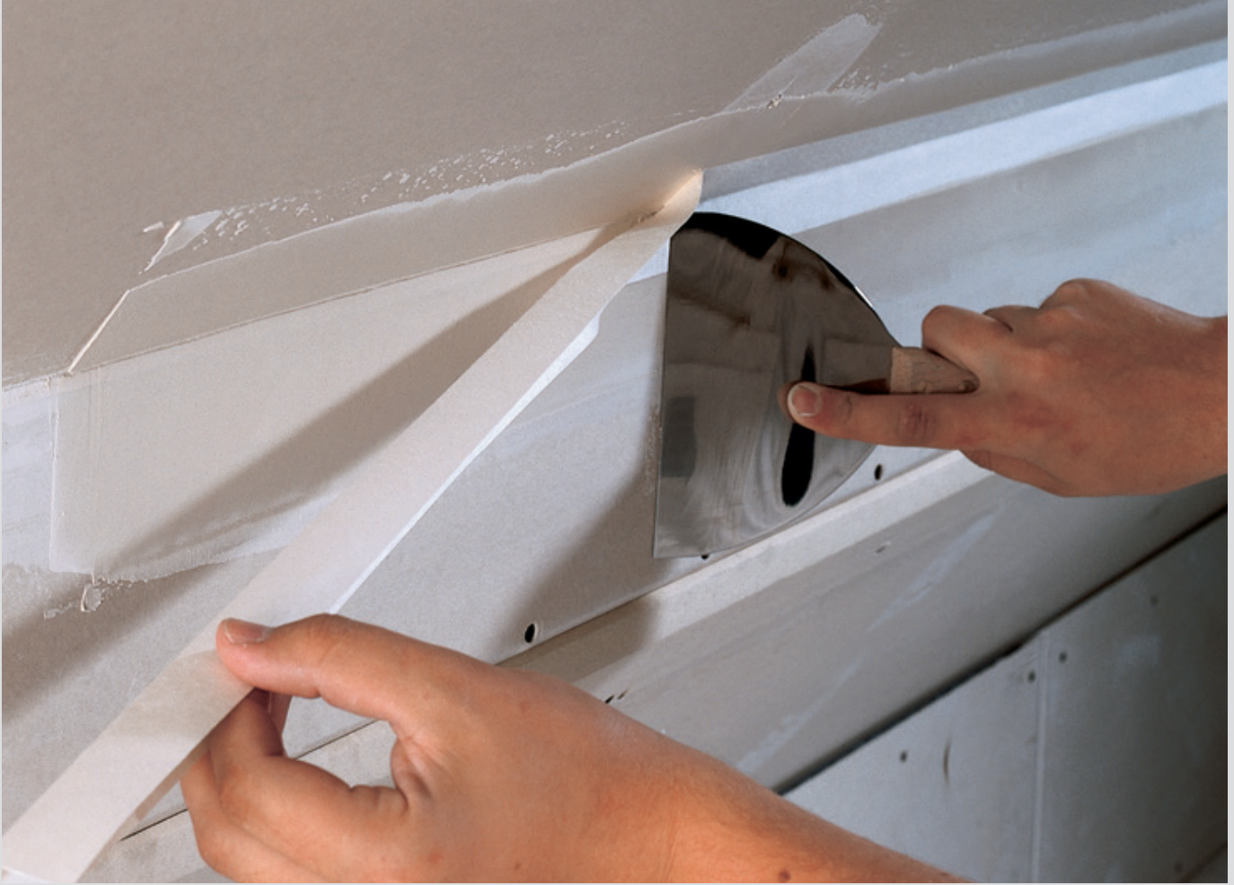
Tavan arasında Kurt Kağıt Derz Bandı ile çatlakların önlenmesi
