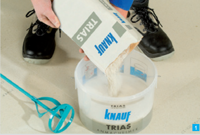
Knauf TRIAS'ın kaba dökülmesi
