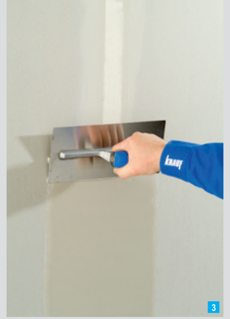
Derz bandı eğik yüzeyli mala ile kapatılır.
