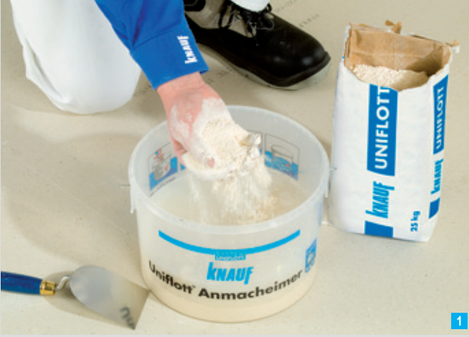
Knauf Uniflott® veya Knauf Fugagips®'in sepelenererek dökülmesi
