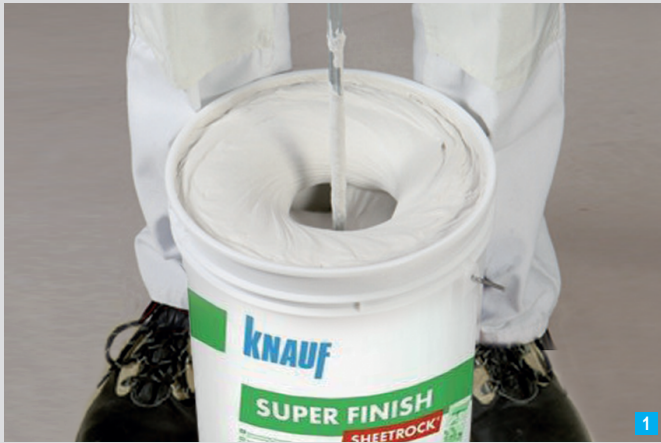
Knauf Superfinish'i mikser ile karıştırın.
