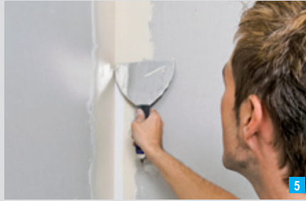
Hızalı biçimde dolgu ile kapatılır.
