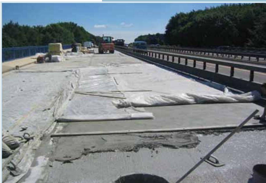
▲ Autoceļa tilta braucamās virsmas reprofilēšanas un labošanas piemērs
