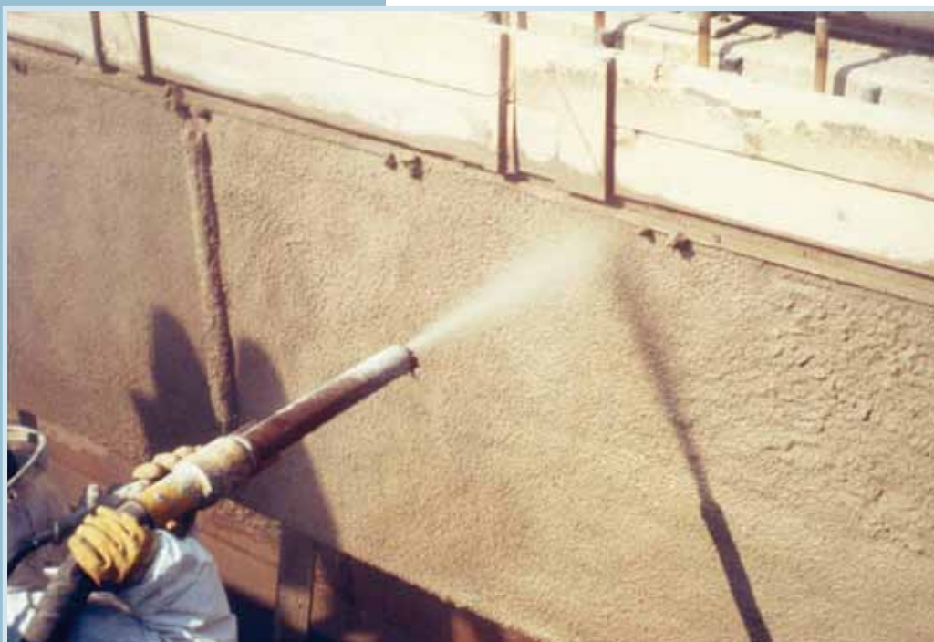
« Torkret betona uzklāšanas slapjā veidā piemērs
