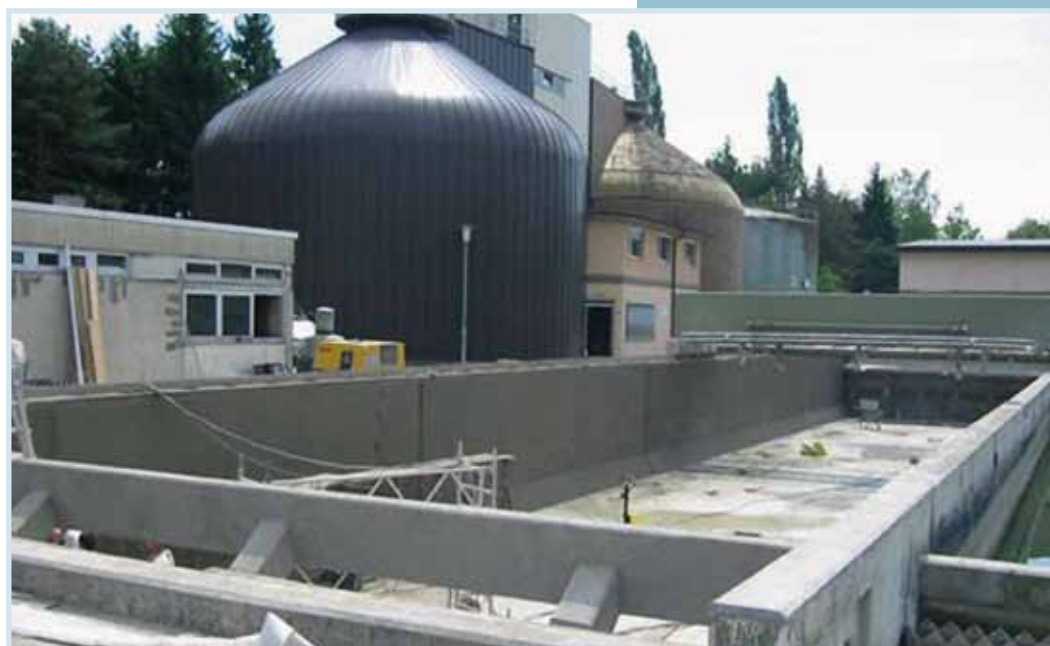
►► Nosēdbaseina sānsienu reprofilēšana notekūdeņu apstrādes iekārtā
