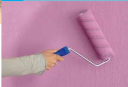
Smalki optisku virsmu Jūs varat iegūt, to vienmērīgi norullējot ar *Knauf EASYPUTZ* apmetuma noformēšanai paredzēto *Knauf Finishwalze* rullīti.
