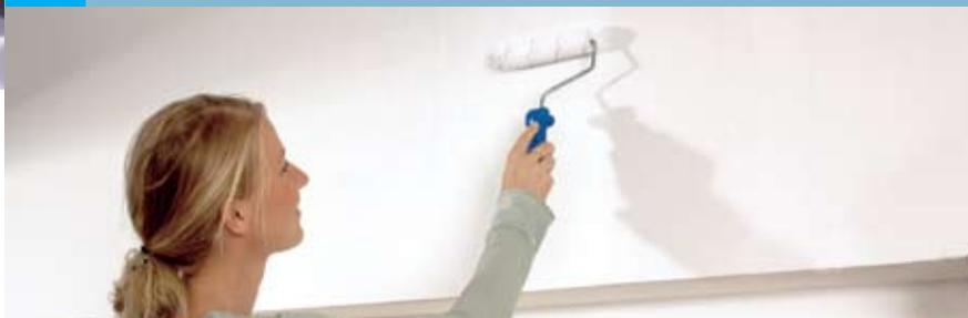
Pārbauda pamatnes noturību, t.i., vai pamatne ir stingra, bez smilšu un krīta paliekām. Tapetēm jāpārbauda, vai tās stingri turas pie sienas. Noslēgumā sienu gruntē ar *Knauf Sperrgrund*. Ja pēc *Knauf Sperrgrund* uzklāšanas zem tapetēm veidojas burbulji, virsma nav pietiekami noturīga, un tapetes no sienas ir jānoņem.
