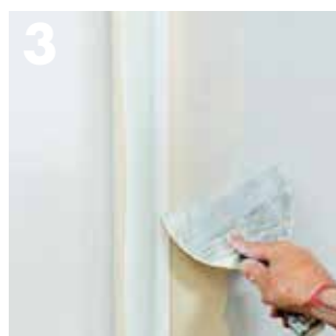
Fjern overskydende spartelmasse med spartlen (eller en fugtig svamp), og pas på, at der ikke er luftbobler under papiret. Lad det tørre.
