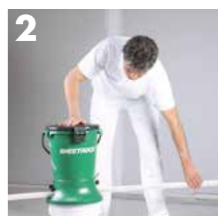
Hjørnelisten trækkes gennem Hopperen med Knauf ProSpray Plus eller Knauf Easy Filler Light Tool.
