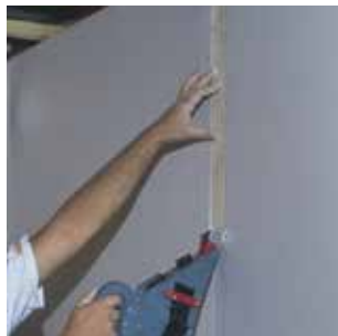
Hjørnespartling. Maskinen holdes i 45°
