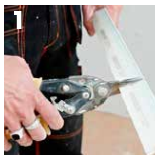
Mål hjørnets længde, og klip den ønskede længde hjørneliste af med en pladesaks. Ved lodrette væghjørner skal hjørnelisten være 10 mm kortere end væghøjden.
