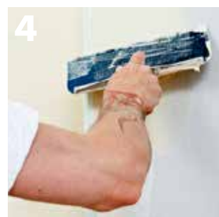
Anden og tredje lag spartling udføres med en bred spartel og jf. vejledning på side 8.
