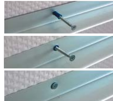
Coloque y atornille
