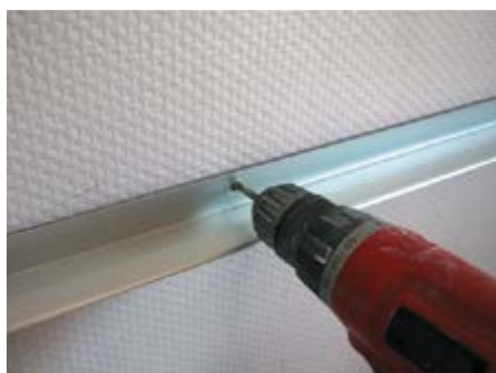
Coloque el perfil de 1200 sobre la línea y perfore los 3 agujeros
