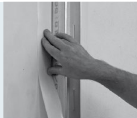
Pasirinktinai priklijuoti Knauf Trenn-Fix sandūros juostą ant prijungiamos konstrukcinės dalies.
