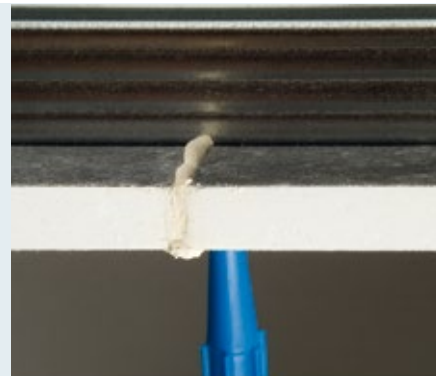
Siūlės užpildymas Knauf Uniflott glaistu, vaizdas iš šono.
