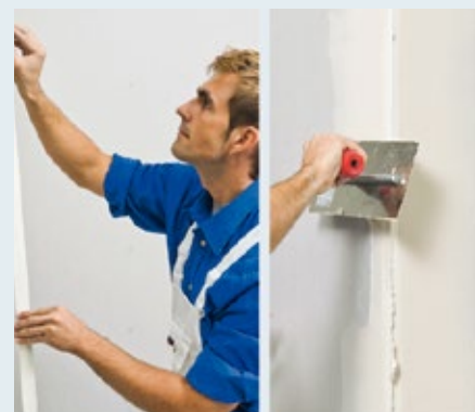
... įstatoma į glaistą ir išlyginama.
