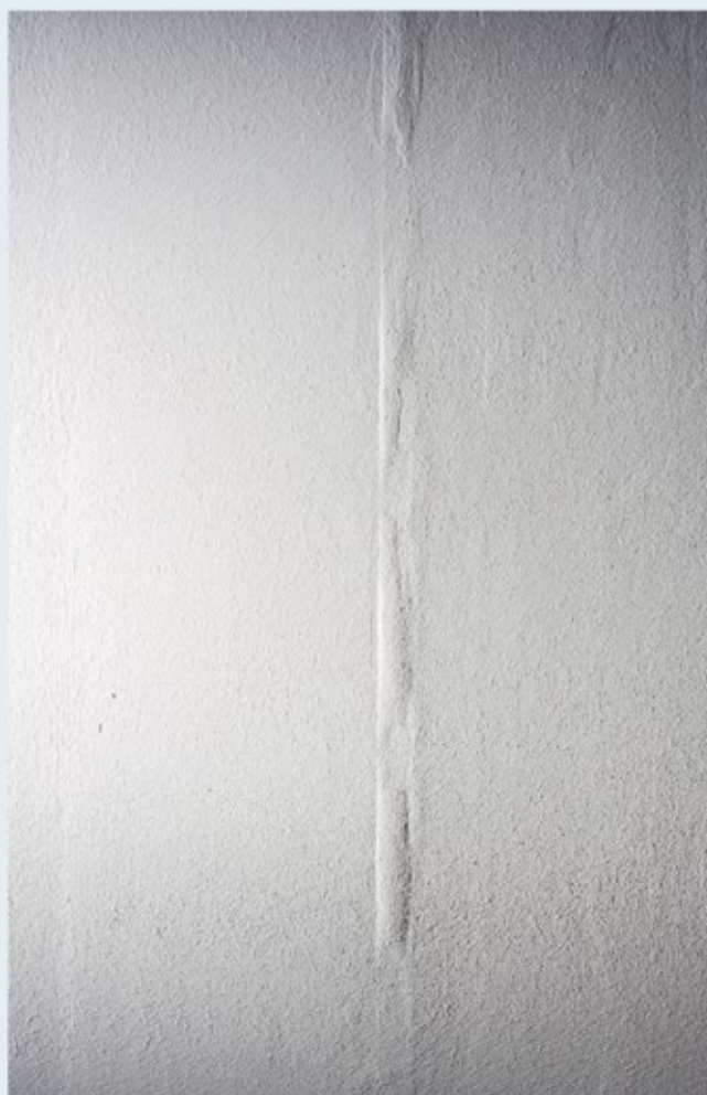
Priežastis – per mažai glaisto po armavimo juosta SK briaunos pusėje (į kairę nuo siūlės centro).
