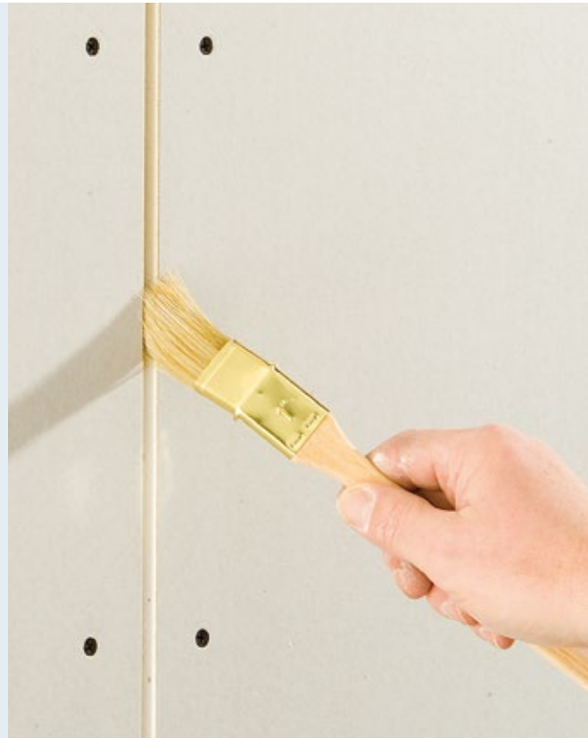
Siūlės gruntavimas, pavydžiui, Knauf Tiefengrund .
