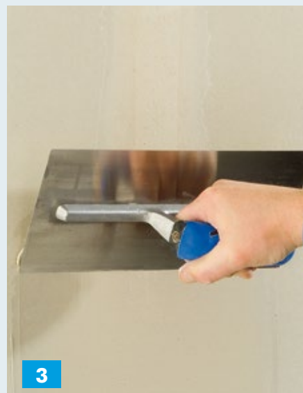
Užglaistyti siūlių armavimo juostą.
