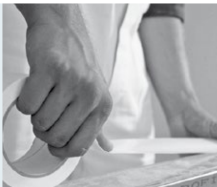
Lipniąją sandūros juostą Knauf Trenn-Fix klijuoti ant CW arba UW profilio.
