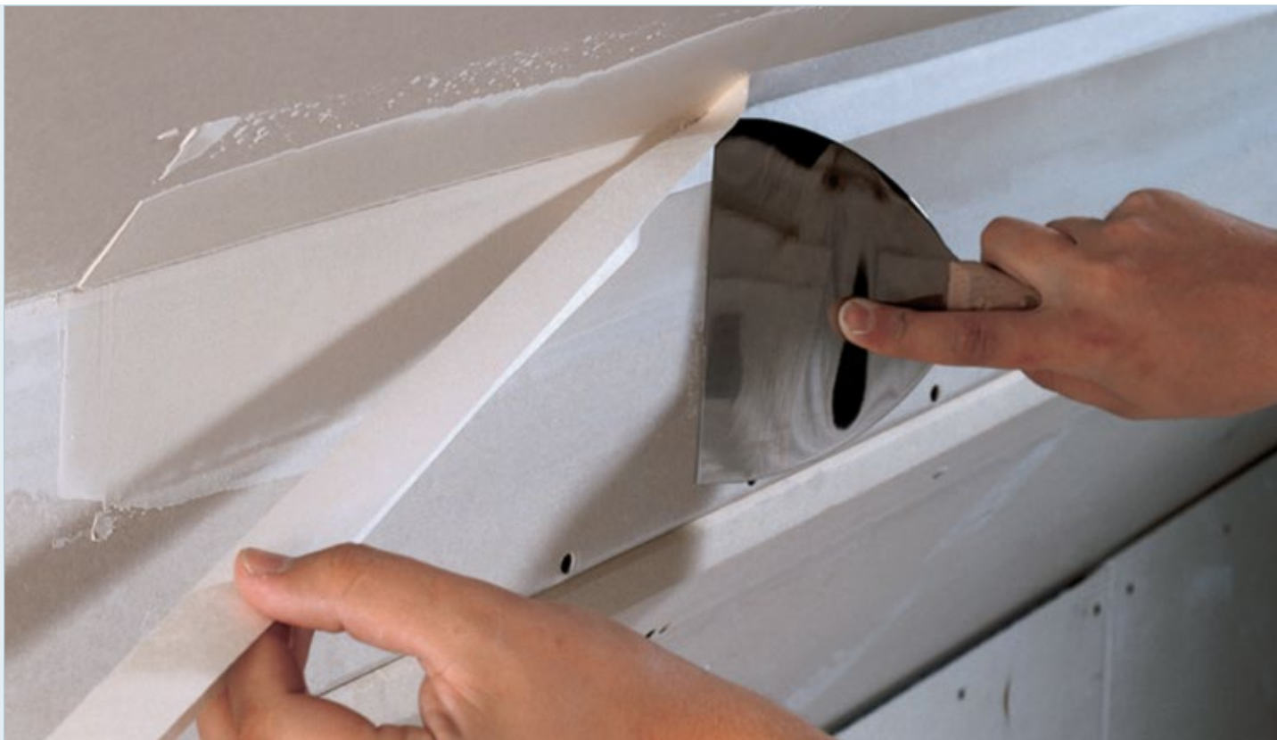
Tinkamas siūlių glaistymas, naudojant Knauf Kurt armavimo juostą mansardoje.
