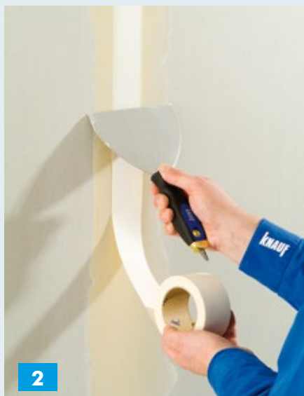
Į glaistą įplukdyti Knauf Kurt armavimo juostą.
