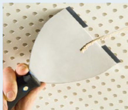
Likučių nuėmimas po to, kai Knauf Uniflott glaistas sukietėjo. Naudojamas Cleaneo-Spachtel glaistiklis.
