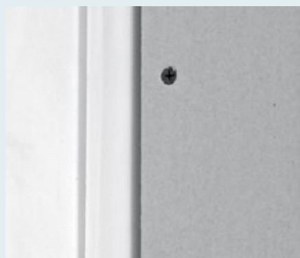
Knauf plokštės sumontuoti, paliekant 5 mm tarpą nuo besiribojančios konstrukcijos.
