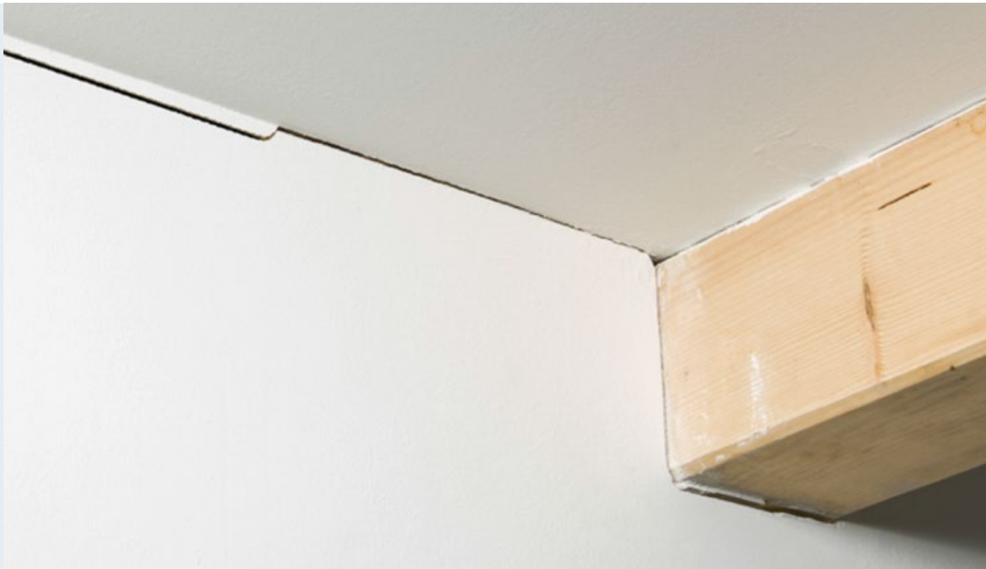
Nelygus trūkis, susidaręs dėl neatskirtų konstrukcijų.
