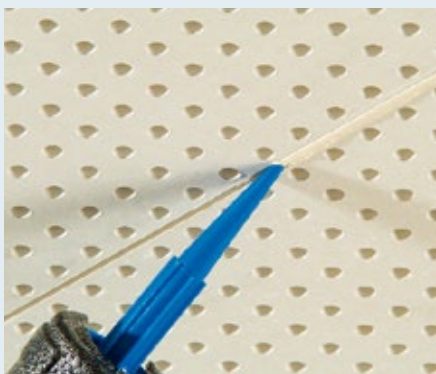
Siūlės užpildymas Knauf Uniflott glaistu.
