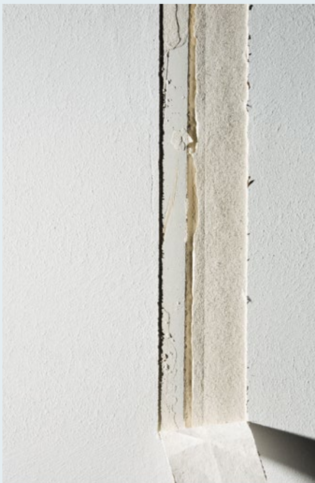
Pusės arba dalies armavimo juostos atšokimas, matomas po dažymo.
