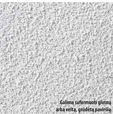
Tinkamai sureguliuota temperatūra meno muziejuje. Sienose įrengta šildymo sistema, padengta tinku Knauf MP 75 G/F.
