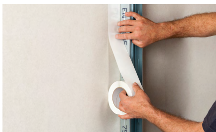
2. Juosta Trenn-Fix klijuojama šalia profilio
