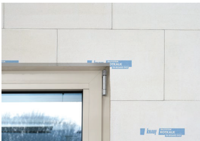
5. attēls: Plākšņu ieklāšana pie logu un durvju ailēm
