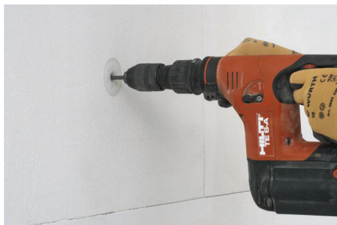
8. attēls: Nostiprināšana ar dībeļiem
