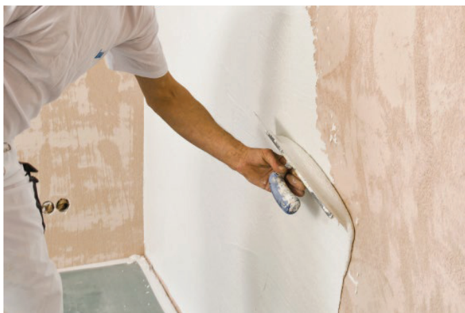
12. attēls: Virsējā apmetuma uzklāšana
