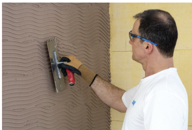
10. attēls: Armējošās kārtas uzklāšana
