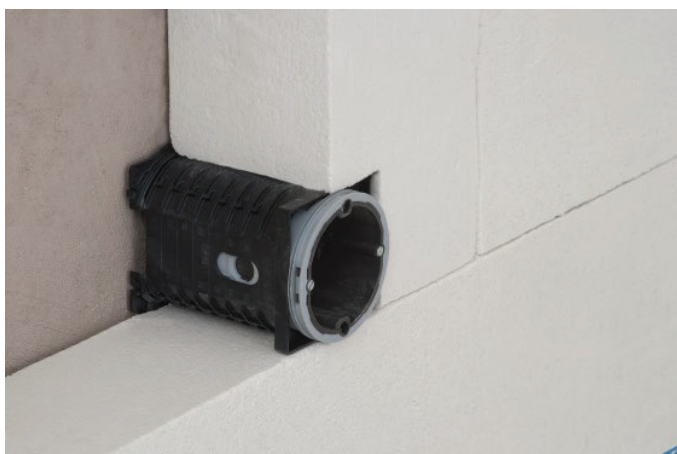
17. attēls: Elektroinstalāciju kārbu iemontēšana
