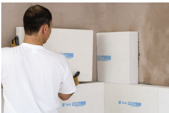
6. attēls: Plākšņu ieklāšana stūru zonās
