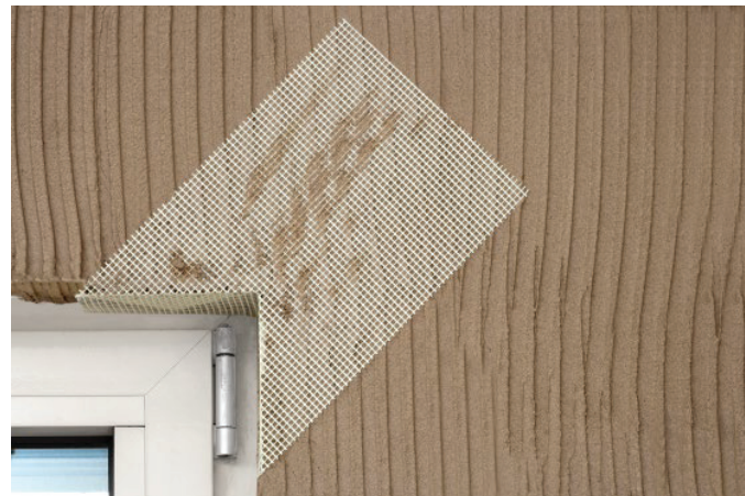
14. attēls: Sienu atveru veidošana
