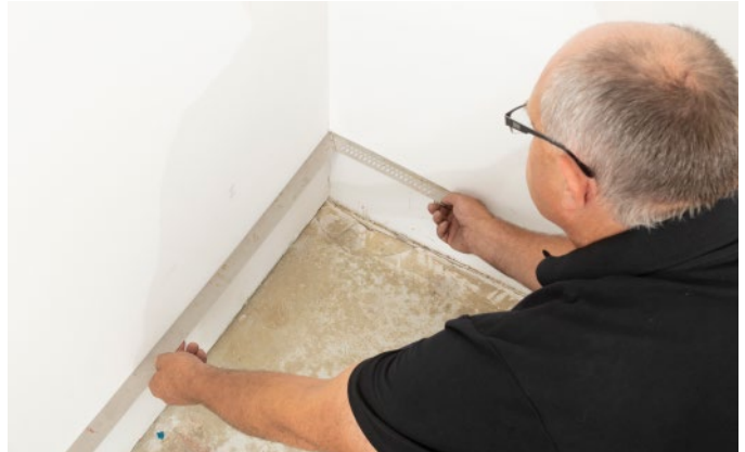
Bild 4: Prüfung Rechtwinkligkeit
