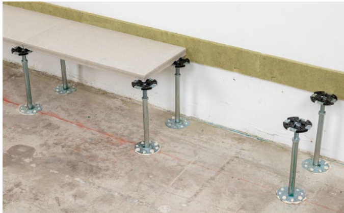
Bild 22: Montage leichter Rasterstab
