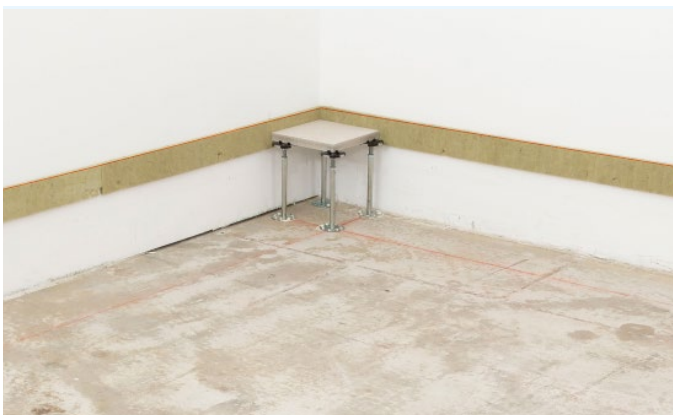
Bild 12: Systembodenstützen einrichten und im Wandanschlussbereich montieren
