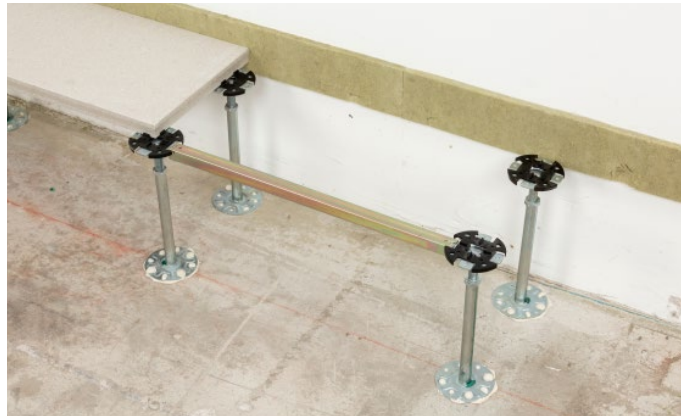
Bild 24: Montage schwerer Rasterstab
