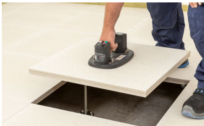
Bild 19: Anheben mit Saugheber
