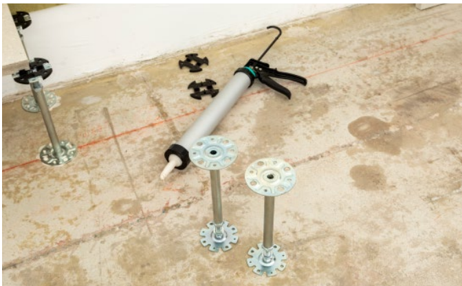
Bild 15: Positionieren weiterer Stützen
