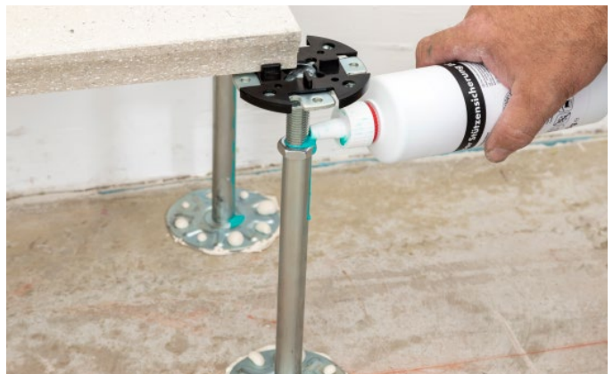
Bild 14: Doppelbodenelement im Wandanschlussbereich montieren
