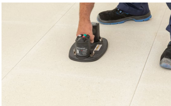
Bild 21: Doppelboden mit Doppelbodenelement erneut verschließen
