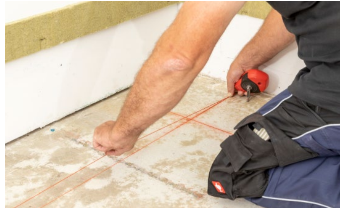
Bild 8: Linie für erste Stützenreihe anzeichnen
