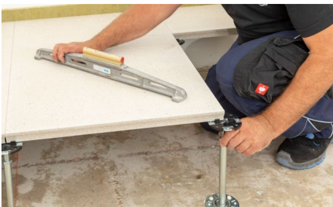
Bild 17: Ausnivellieren der Doppelbodenelemente
