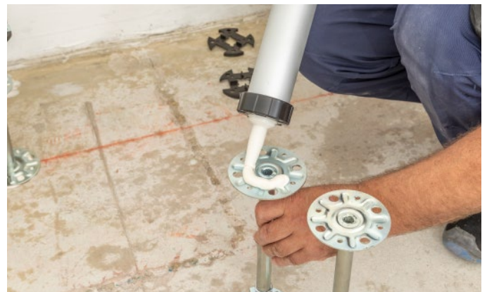
Bild 9: GIFAfloor Stützenkleber auftragen
