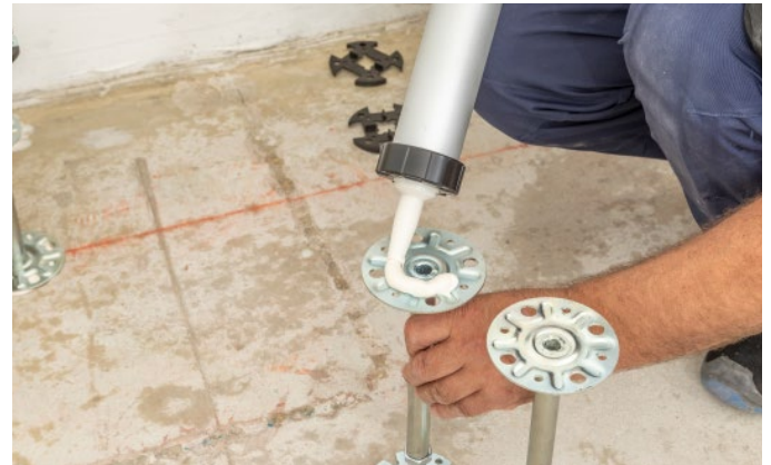
Bild 9: Apply GIFAfloor pedestal adhesive
