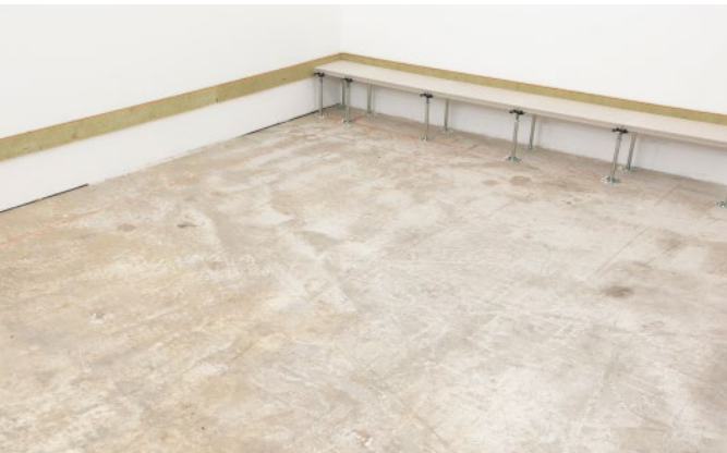
Bild 16: Installing the first row of Knauf GIFAfloor DB green panels
