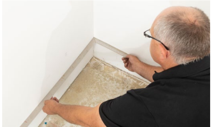
Bild 4: Checking perpendicularity
