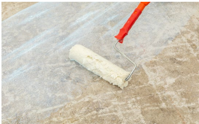
Bild 2: Prime the raw floor
