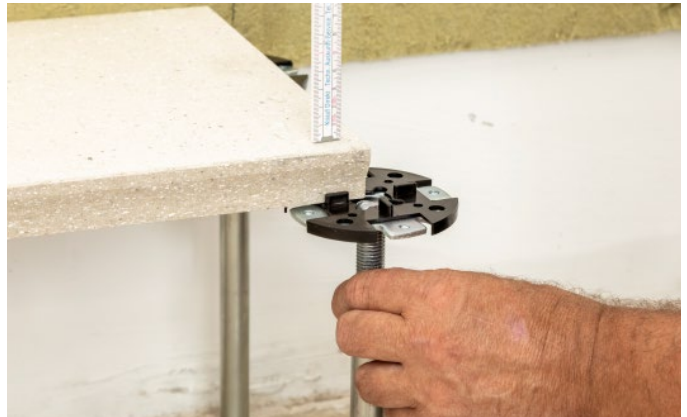
Bild 13: Set up reference height
