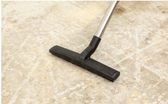
Bild 1: Rohboden reinigen
