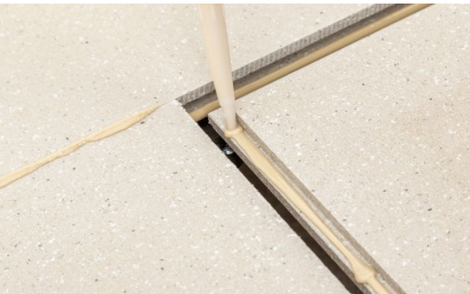
Bild 16: Auftrag des Klebstoffs
