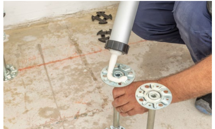
Bild 9: GIFAfloor Stützenkleber auftragen
