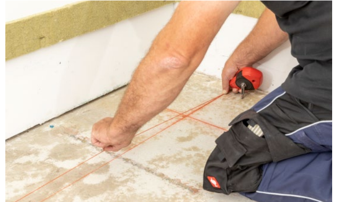
Bild 8: Linie für erste Stützenreihe anzeichnen
