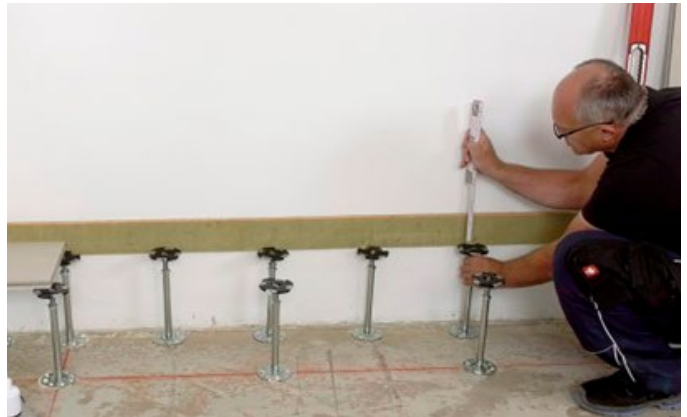
Bild 13: Bezugshöhe einrichten
