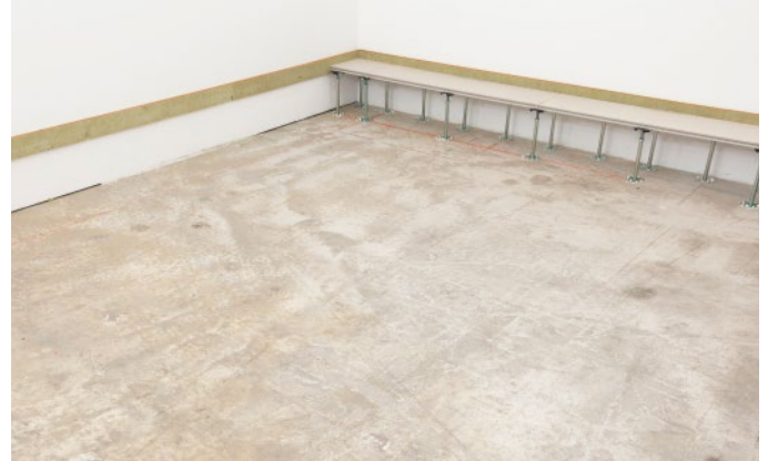
Bild 18: Höhe der GIFAfloor Systembodenstützen einstellen und mit Wasserwaage oder mit Laser kontrollieren.
