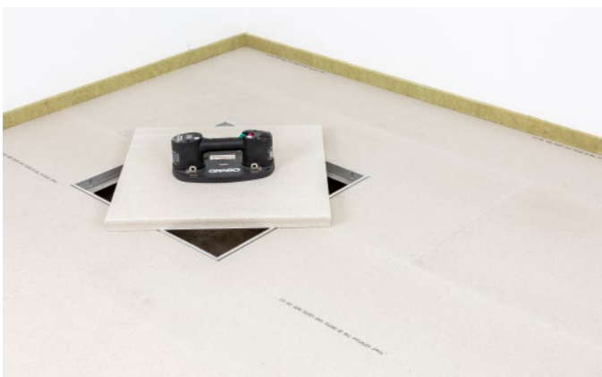
Bild 21: Öffnen der Revisionsöffnung mit Vakuumsaugheber
