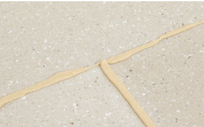
Bild 17: Austretender Klebstoff zeigt ausreichende Menge an.
