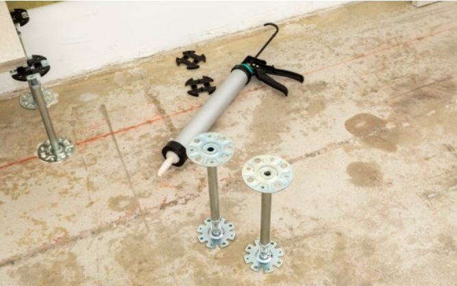
Bild 15: Positionieren weiterer Stützen
