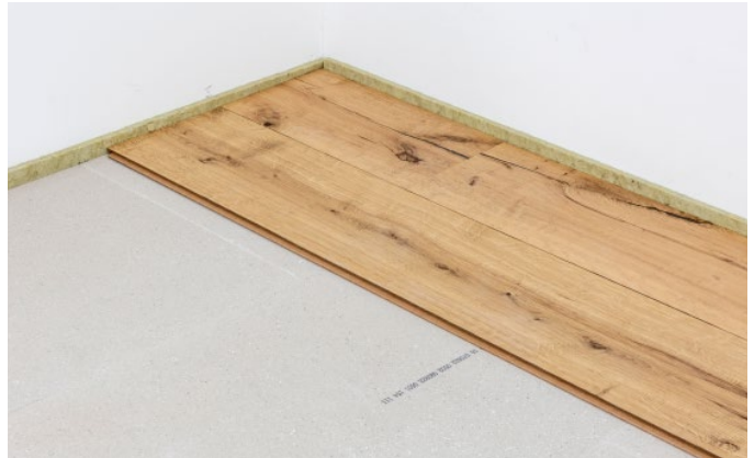
Bild 23: GIFAfloor Randdämmstreifen MW nach Verlegung des Oberbelags umlaufend bündig abschneiden
