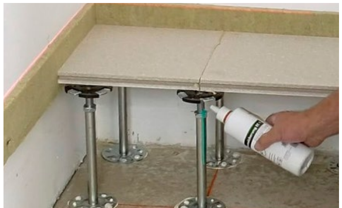
Bild 14: Flächenhohlbodenelement im Wandanschlussbereich montieren
