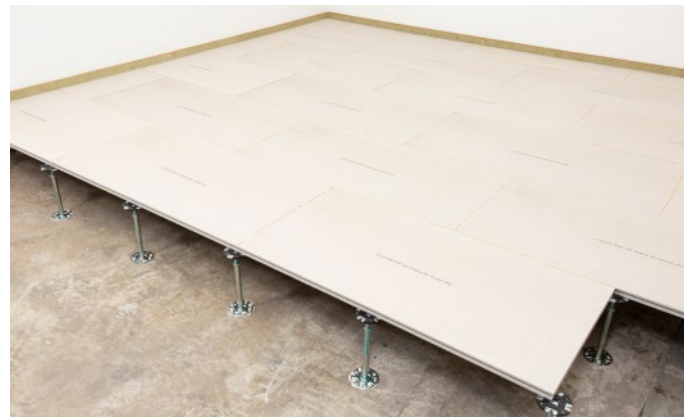
Bild 19: Installation weiterer Flächenhohlbodenelemente
