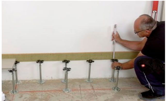
Bild 13: Set up reference height
