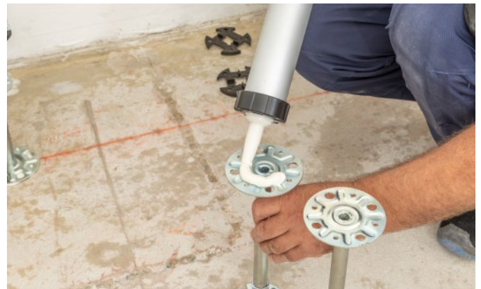
Bild 9: Apply GIFAfloor pedestal adhesive
