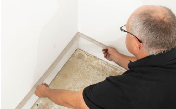
Bild 4: Checking perpendicularity
