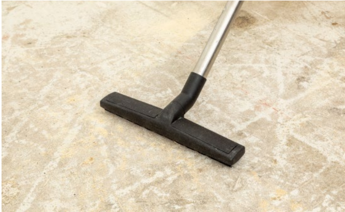
Bild 1: Clean the raw floor
