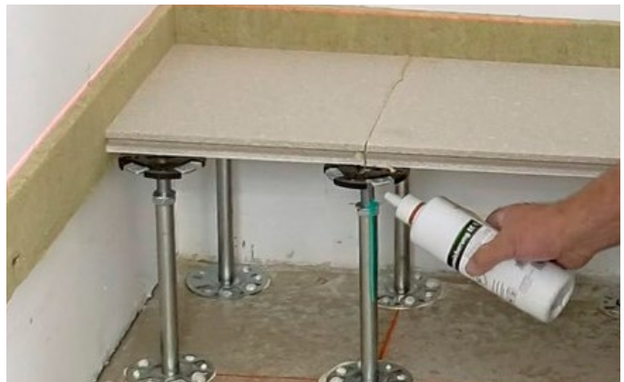
Bild 14: Apply the GIFAfloor Thread Sealer
