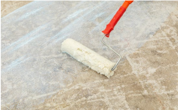
Bild 2: Prime the raw floor
