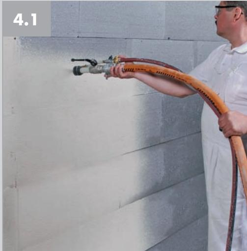
**4.1** Auf die fertig gedübelte Fassade\* wird der Armierungskleber gleichmäßig mit dem Spritzgerät für Zier- und Armierungsputz aufgespritzt. Dies erleichtert das Einbetten des Armierungsgewebes und das aufwendige Glattziehen kann entfallen.
