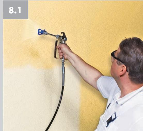
**8.1** Das nebelarme Spritzen mit Airless-technologie rundet das Komplett-System zum Erstellen der WDVS-Fassade ab.
