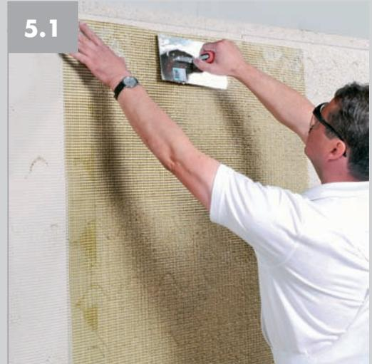
**5.1** Faltenfrei, oberflächennah und vollständig wird das Armierungsgewebe in den Kleber eingebettet, zum Beispiel mit Hilfe einer PFT Glättkelle. Damit das Armierungsgewebes richtig eingebettet ist, wird nochmals eine Schicht Armierungskleber aufgespritzt. Das aufgetragene Material im Anschluss glattziehen.
