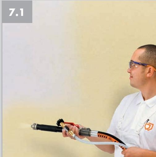
**7.1** Maschinelles Auftragen des Oberputzes. Strukturierung mit der Maschine plus Spritzgerät für Oberputze.
