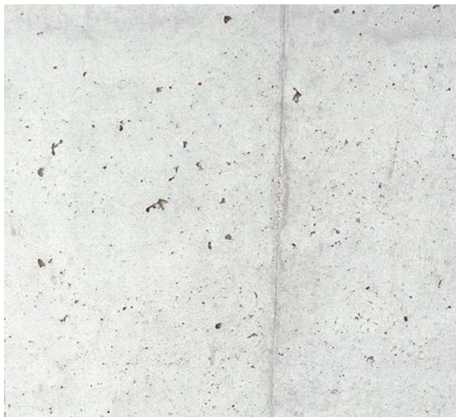
„Verlag Bau+Technik GmbH“ nuotr. Betonas su uždaro struktūros paviršiumi
