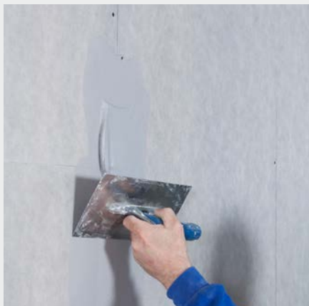
1 žingsnis: užpildykite siūlę glaistu Knauf Drystar-Filler
