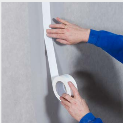
2 žingsnis: įdėkite siūlių armavimo juostą Knauf Kurt
