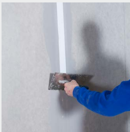
4 žingsnis: siūlę dar kartą nuglaistykite glaistu Knauf Drystar-Filler
