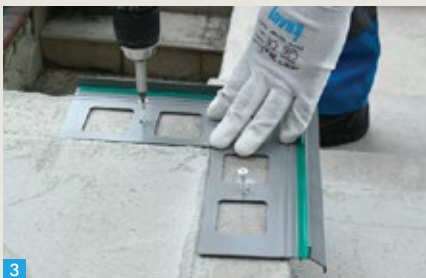
3 Pridėti kampą montavimo vietoje, pažymėti tvirtinimo taškus, nuimti kampą, išgręžti skyles, įkalti skečiavuosius kaiščius, po kampais padengti Flex-Dicht hidroizoliacijos sluoksnį, vėl pridėti kampą ir prisukti kaiščių savisriegius iki vidurio.
