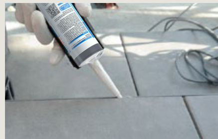
Užpildyti siūles hermetiku. Naudoti Sanitär-Silicon.
