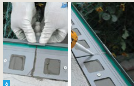
6 Sumontuoti profilių jungtis iš viršaus ir iš apačios. Plyšius tarp profilių užpildyti hermetiku, pvz., Sanitär-Silicon.
