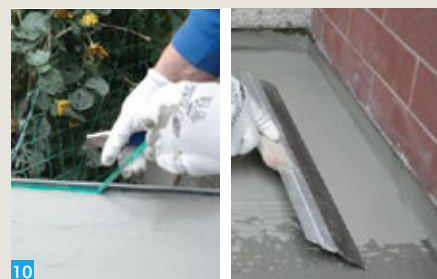
10 Užtepęs pirmą hidroiziacijos sluoksnį, nuimti profilių perforaciją apsaugančią juostą. Kai pirmas mišinio sluoksnis išdžiūvus, padengti kitą sluoksnį.
