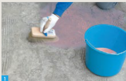
1 Padengti paviršių gruntu Spezialhaftgrund.
