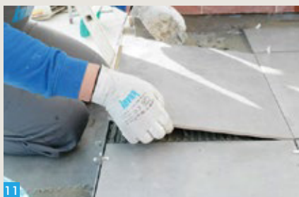
11 Sukloti plyteles. Jas klijuoti itin elastingais klijais K4.
