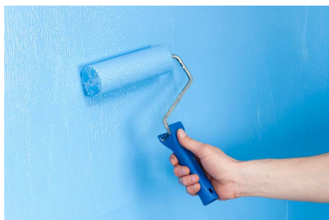
4. Drėgmės veikiamos vietos dengiamos min. dviem hidroizoliacijos sluoksniais.
