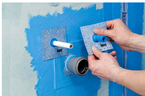
3. Kampuose, sienų jungčių zonose, vamzdžių išvadų, grindų trapų vietose įplukdomi hidroizoliaciniai priedai.
