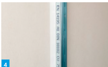
4. Trenn-Fix juostą prispausti ir išlyginti.
