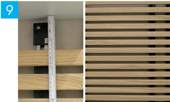
Abschluss zur Decke mit KDLF Enddrehklipp. Mindestabstand zum Deckenanschluss 10 mm.
