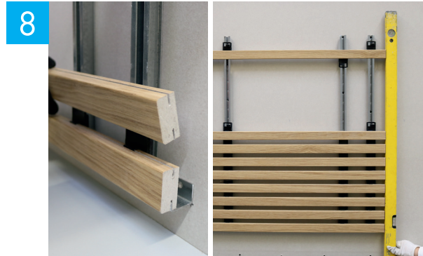
5-7 wiederholen, ab Wandhöhe \geq 3\text{m} neue KDLF Anfangsschiene horizontal setzen.
