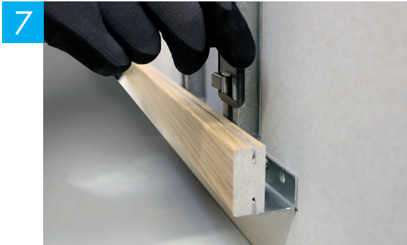
Kraftschlüssige Fixierung der DESIGNLINE mithilfe der herabgeschobenen KDLF Fugendrehklipps.
