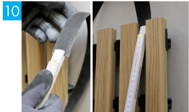
KDLF Dämmfedern einziehen. Tipp: hierzu eignet sich ein Zollstock, zum Transport in den Nuten.
