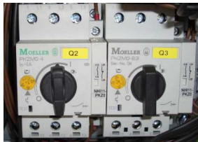
Abb. 1 Motorschutzschalter
