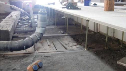
Auf etwas insgesamt 2.000 Hohlbodenstützen wurde der GIFAfloor-Flächenhohlboden verlegt. Dank der justierbaren Stützen konnten Höhenunterschiede bis zu 480 mm überbrückt werden. Das Bodensystem integriert alle Versorgungsleitungen für die neuen Zimmer.
