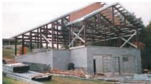
2. Μεταλλική κατοικία με συστήματα ξηράς δόμησης Knauf υπό κατασκευή
