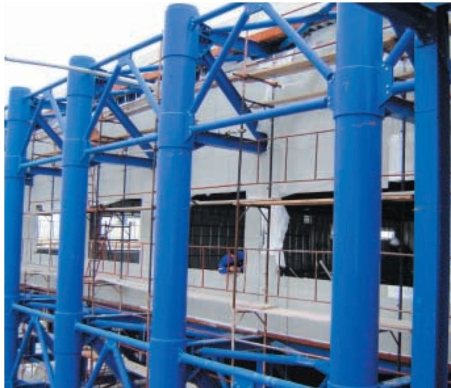
1. Νέα βιβλιοθήκη T.E.I. Πειραιά. Κατασκευή τοίχων με συστήματα ξηράς δόμησης Knauf
