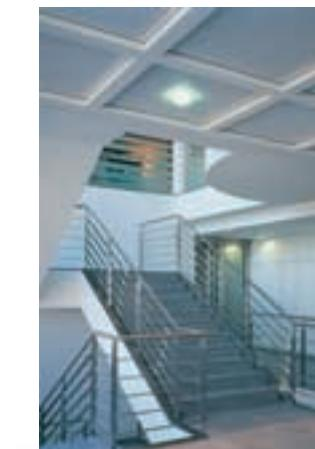
Οροφές με κάναβο οριοθετούν τους χώρους διέλευσης και αποδεικύουν πλαστικά πάς μπορούν να κατασκευαστούν αυτόνομες οροφές από γυψοσανίδα υψηλών ακουστικών επιδόσεων.
