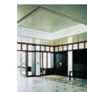
Χωρίς αρμούς συνδέεται η οροφή με τους πλευρικούς τοίχους. Ο μεταλλικός σκελετός προκατασκευάστηκε στο εργοστάσιο προκειμένου να εξασφαλιστεί το σχέδιο φωτισμού.
