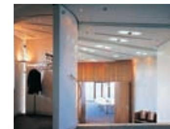
Οι σχισμές των γυψοσανίδων στην οροφή καθόδου του κλιμακοστασίου προς την αίθουσα συνεδριάσεων κατασκευάστηκαν με ανάστροφο φρεζάρισμα σχήματος Λ.
