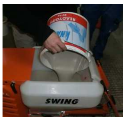
Illustration 28 : Remplissage du réservoir de matériau
