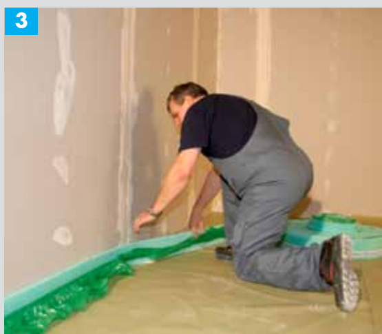
Pēc neapstrādātas pamatnes (melnās grīdas) pārklāšanas pie sienām un kolonnām piestiprina malu izolācijas lenti, lai novērstu "skaņas tiltu" uz blakus esošajām būvdetaļām un nodrošinātu skaņas izolāciju
