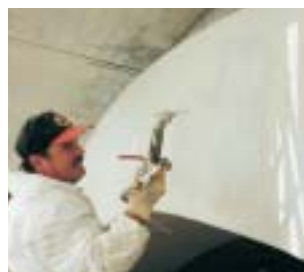
Der Abschluss von drei Arbeitsschritten: Grobmörtel zum Auffüllen, Feinspachtel für eine ebene Oberfläche und zuletzt die Oberflächenschutz-Beschichtung. Das alles angemischt und gepumpt mit einer PFT Maschinenkombination: MULTIMIX und N 2.
