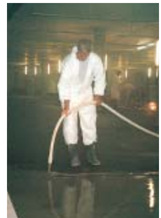
Mit dem Mörtelschlauch PFT RONDO war das Vergießen des Zement-Fließmörtels ein Leichtes.
