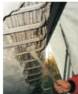
Sehr gut zu erkennen: Diese groben Betonausbrüche hieß es für die Firma Kagerer zu reprofilieren.
