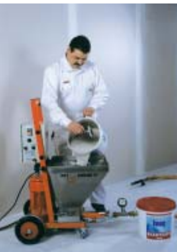
Leichtes Befüllen des Edelstahl-Materialtrichters mit der verarbeitungsfertigen Spachtelmasse aus dem 20 kg Eimer.
