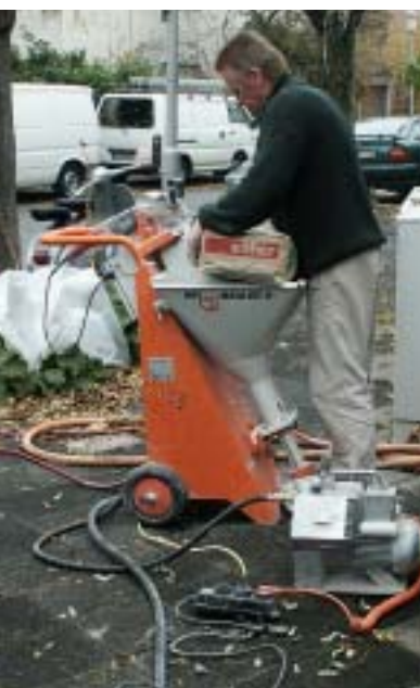
Arbeiten im Akkord: Maschine mit Material befüllen, mischen, pumpen, spritzen, ab in den Transporter und auf zur nächsten Baustelle.
