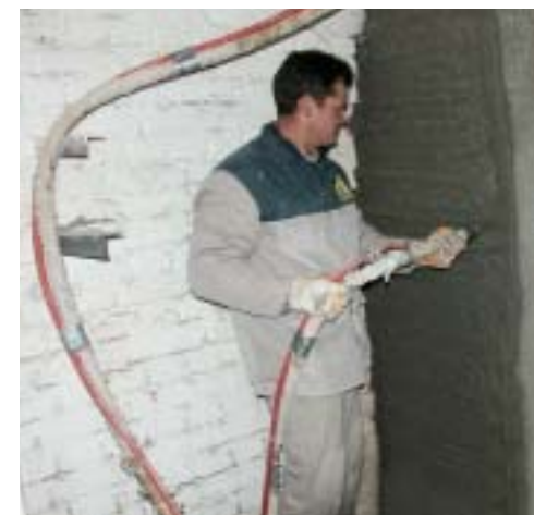
Durch das Kellerfenster fördert die Mischpumpe PFT MINIJET II das Material genau in der richtigen Konsistenz direkt zum Verarbeitungsort.
