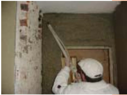
Die verwendeten Materialien, von Knauf MP 75 L bis Kalk-Zement-Putz, waren problemlos mit der PFT Maschinenteknik zu verarbeiten.
