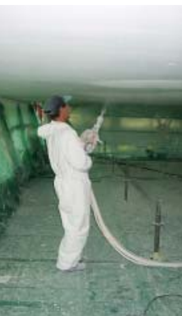
Dank der Kombination Förderpumpe und Luftkompressor von PFT konnte der Oberputz problemlos auf die Dämmplatten aufgespritzt werden.
