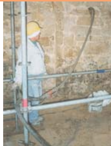
Die Bohrlöcher für die Edelstahlanker zur Konsolidierung des Mauerwerkes wurden maschinell verpresst.
