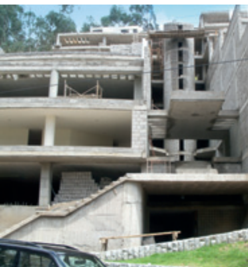
Neubau einer Villa in der landestypischen Zementblock-Bauweise.
