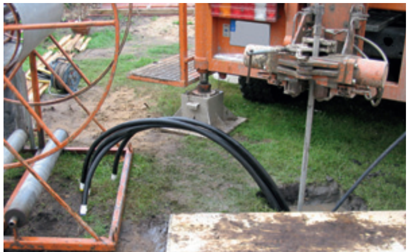
Die 100 Meter tiefen Bohrungen werden hohlraumfrei mit der kontinuierlich arbeitenden Mischpumpe PFT G 4 light II verfüllt.
