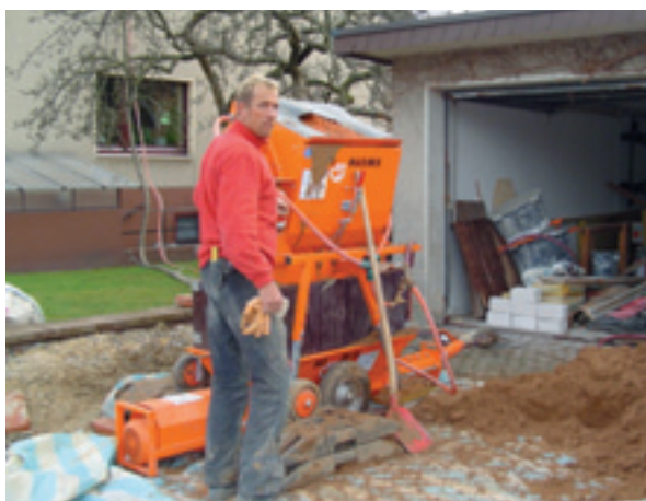
Frank Siebert kann im Ein-Mann-Betrieb, ohne häufiges Chargen-Anmischen, lange Zeit das bevorratete Material verputzen.
