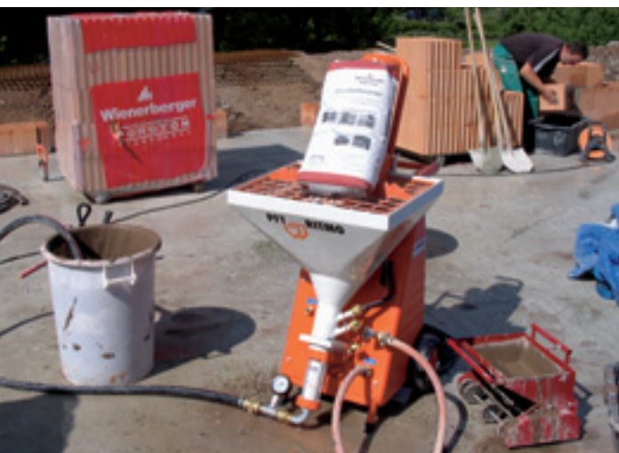
Den ersten Schritt des Planziegel-Bausystems – das Anmischen – übernahm auf der Baustelle in Coburg die Mischpumpe PFT RITMO.
