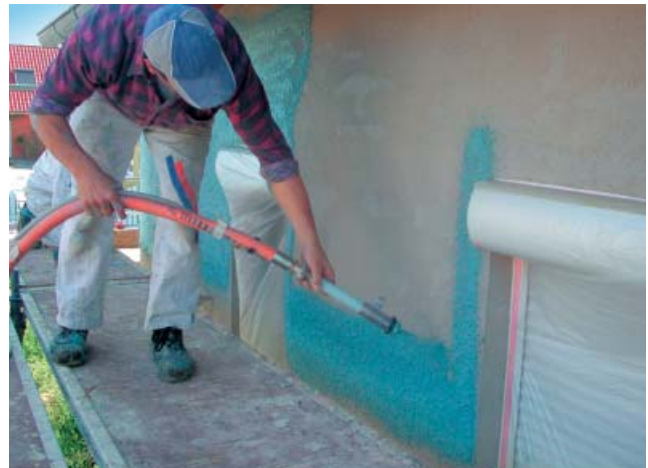
Mit einem 7,5 Meter Materialschlauch wurden mit ca. 8 bar Druck der mineralische Oberputz an die Wand gespritzt.
