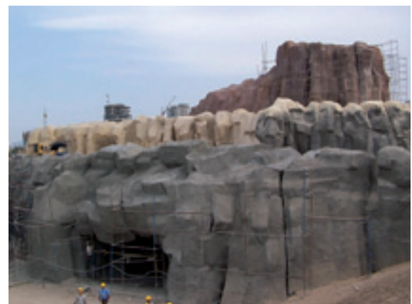
Auf eine Unterkonstruktion wird das Material mit der PFT ZP 3 S aufgetragen, aus dem die künstlichen Felsen geformt werden.
