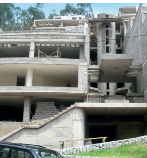
Neubau einer Villa in der landestypischen Zementblock-Bauweise.
