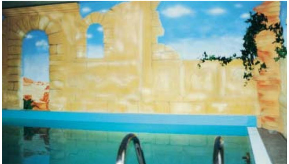
*Nicht alles, was wie Sandstein aussieht, ist auch welcher. Steinreliefs wie diese modelliert Olaf Petersohn mit der Standarddüse einer PFT SWING. Die Grundform wird aus Styropor geschnitzt, die Oberfläche wird aus Armierungsmörtel und Spachtelmasse gestaltet.*
