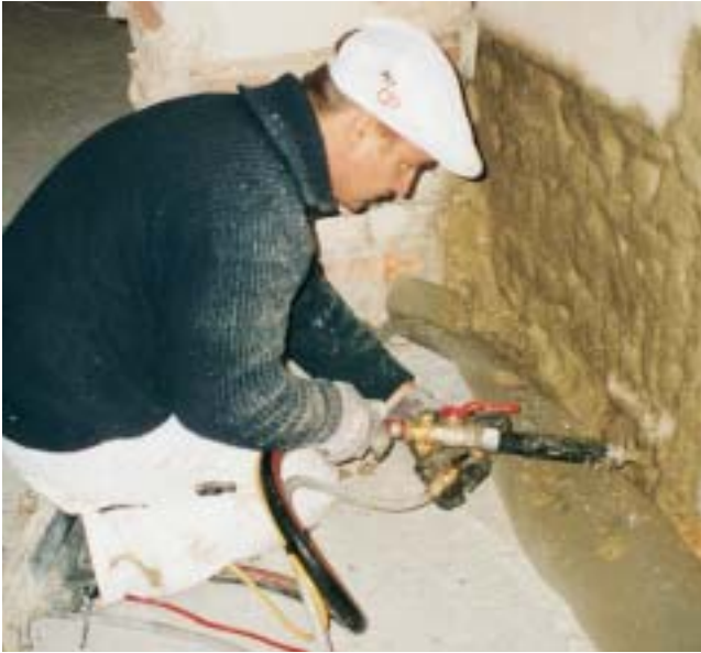
Mauerwerksentsalzung mit sogenanntem "Opferputz". Wirtschaftlich wird das Verfahren durch das maschinelle Aufspritzen mit der PFT SWING. Der aufgetragene Putz wird später wieder abgeschlagen.
