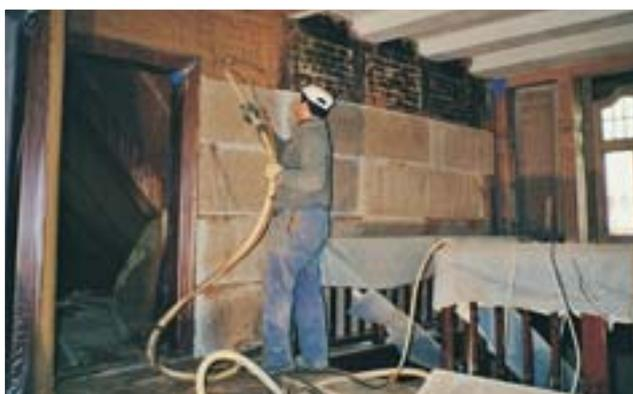
zweite PFT Mischpumpe G 4 gekauft. Auf der Baustelle in Schöppenstedt-Watzum wurde ein rein mineralischer Lehm-Maschinenputz, jedoch absolut faser- und strohfrei, als Werkrockenmörtel in einem 25 Tonnen-silo angeliefert. Die PFT G 4 wurde mit einer Übergabehaube zur vollautomatischen, staubfreien Befüllung direkt unter das Silo geflanscht. Der Maschinen-Lehmputz,
