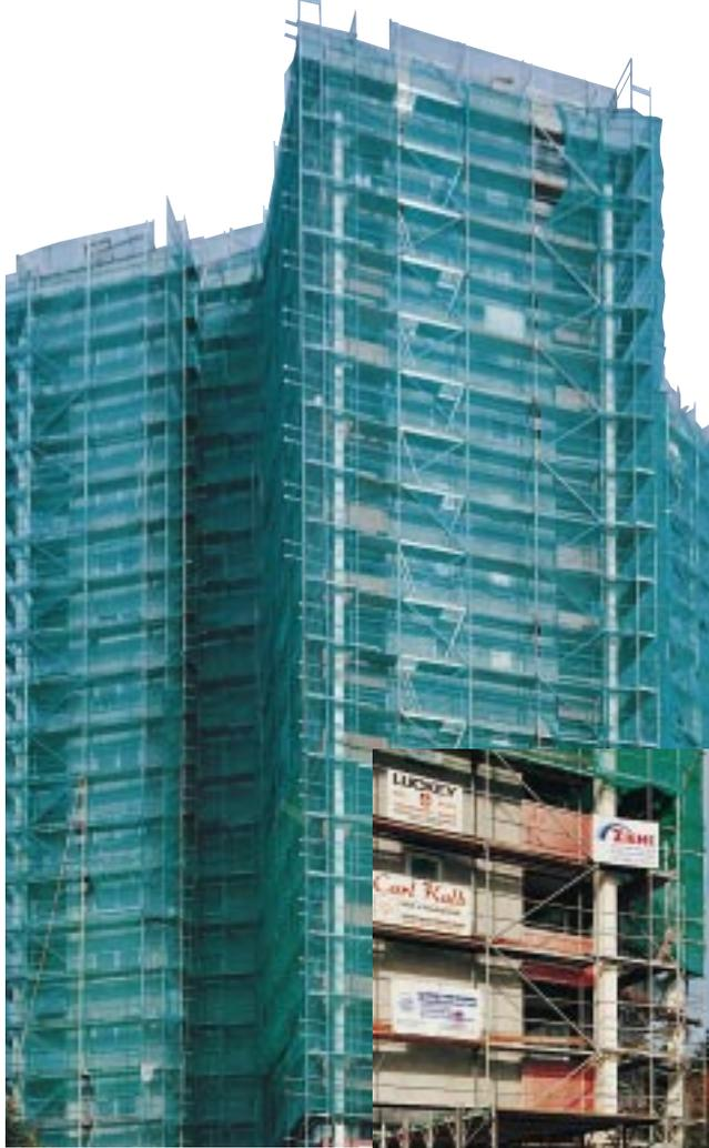
Bei einem 16-stöckigen Altenwohnheim in Kassel stand eine Fassadensanierung an. Die vorgehängte Außenhaut aus Asbestzementplatten sollte durch ein Wärmedämmverbundsystem ersetzt werden. Der Bauherr, die GWG Gemeinnützige Wohnungsbau-Gesellschaft der Stadt Kassel mbH, erteilte den Auftrag an eine Arbeitsgemeinschaft dreier namhafter Kasseler Stuck- und Putzbetriebe, und zwar an die Firmen Carl Kalb GmbH & Co. KG, Ziehe GmbH und Heinrich Luckey GmbH.
