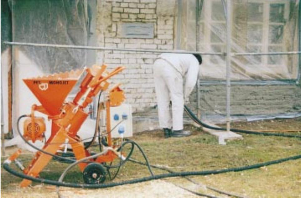
Auch mit 230 V-Wechselstrom sorgt die PFT Putz- und Fördertechnik GmbH & Co. KG, Iphofen mit ihrer neuen Mischpumpe PFT MONOJET Typ 2.13 für den Fluss der Dinge.
