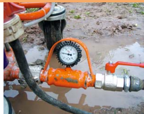
Mit ca. 22 bar Druck verpresste die PFT G 4 den Brunnen-Dämmer von AZ BUT in das Bohrloch.
