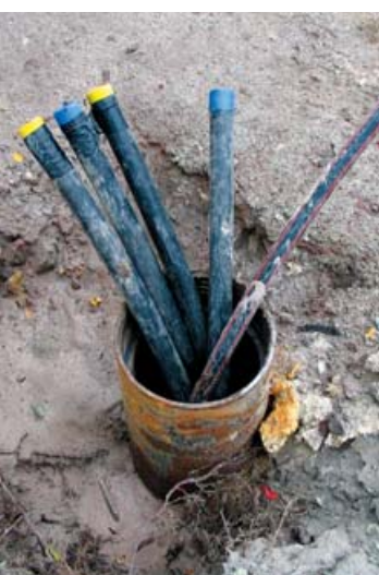
Über die Injektionsleitung verfüllte die PFT G 4 die Hohlräume und sorgte so für eine vollständige Verbindung der Erdwärmesonden mit dem umgebenden Erdreich.
