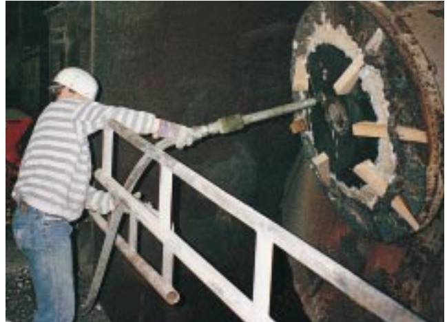
Verpresst wird jetzt maschinell über den angekuppelten Mörtelschlauch.
