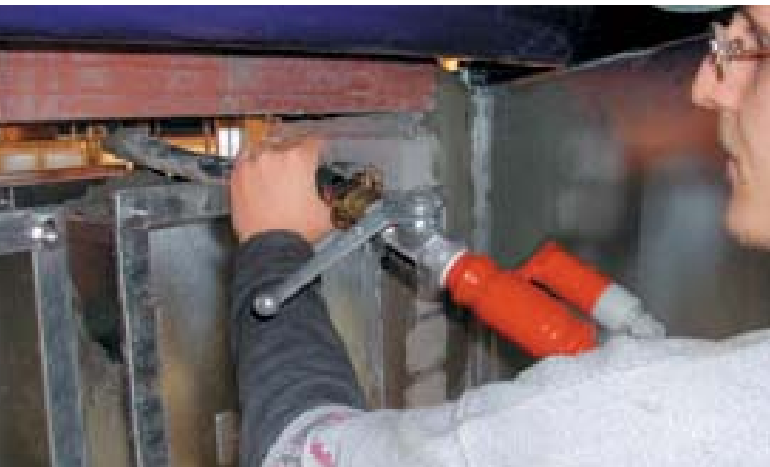
Mit der Klebepistole des PFT JETSET war es ein Leichtes, schwer zugängliche Stellen mit dem Brandschutzmörtel zu verfüllen.
