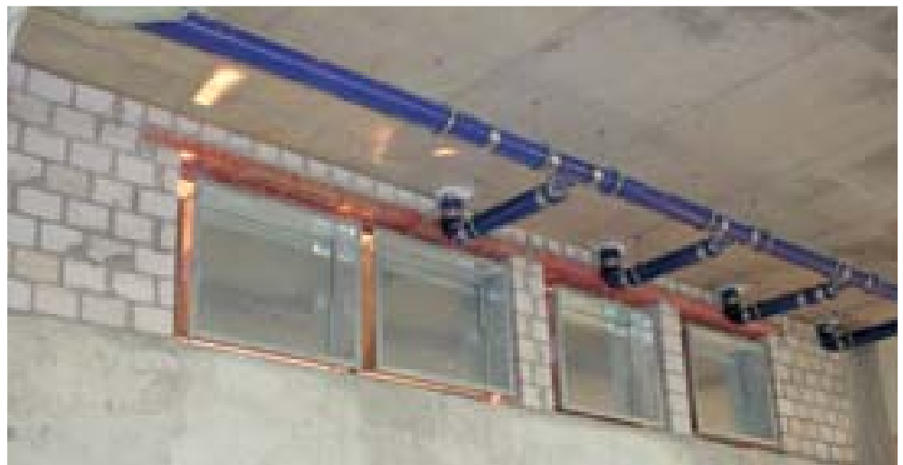
Brandschutzklappen im Versorgungsschacht der Uni-Klinik Würzburg – eine kleine Investition, um eine große Investition dauerhaft zu schützen.
