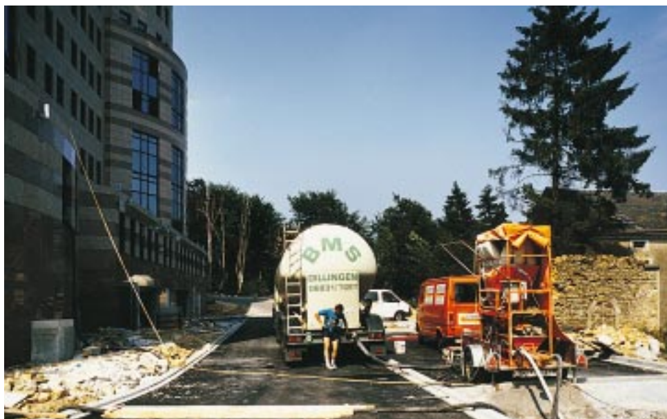
Das auf einen PKW Einachsanhänger montierte PFT Fließestrich-Direktübergabesystem OMP sorgte am Airport-Center Luxemburg in Rekordzeit „für den Fluss der Dinge“.
