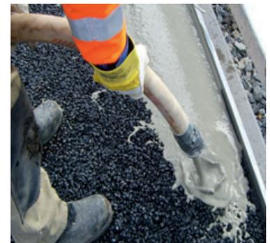
Optimal aufgemischt lief das Schlämm-Material zwischen den Einkornasphaltbelag.
