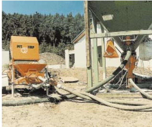
Das Nachblasen des Material-Containers von unten (von links der Schlauch zum Silofahrzeug, rechts zur Einbaustelle) ist selbst während des Vergießens und ohne Beeinträchtigung der Konsistenz möglich.
