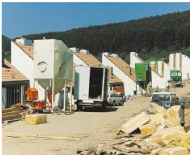
*Der Einsatz der Multifunktions-Fließestrich-Mischpumpe Typ PFT FMP ermöglicht pro Tag 10 bis 12 Wohnungen mit Estrich zu versehen, obwohl mehrmals „umgezogen“ werden muss.*
