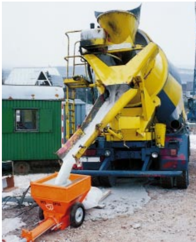
„Volles Rohr“ rauscht der Fließestrich aus der Schütte des Fahrmischers in den Aufgabetrichter der PFT ZP 3 S.
