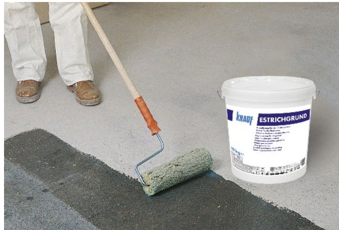
Figure 4: Apply Knauf Estrichgrund screed primer
