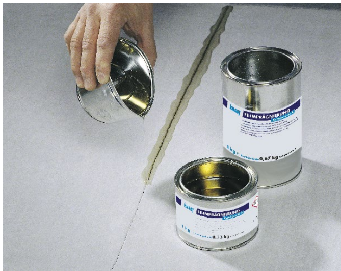
Photo 54: Garnissage des fissures à la résine époxy
