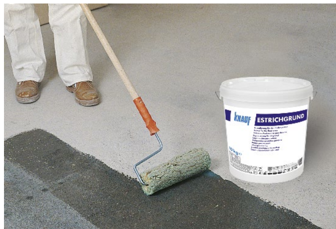
Photo 4: Appliquer l'apprêt pour chape Knauf.
