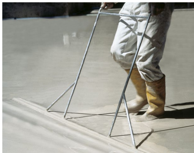
Photo 42: Traitement avec la barre de débullage
