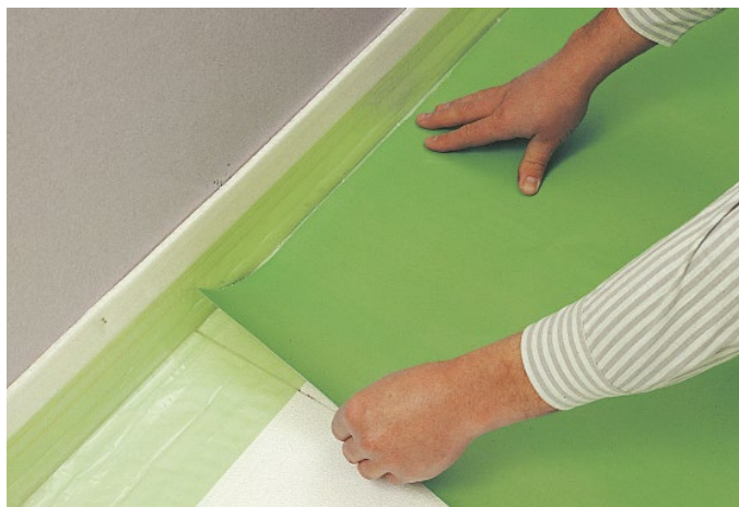
Photo 8: Pose de la couche de séparation Knauf
