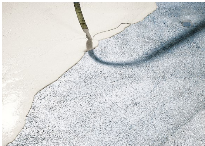
Photo 57: Mise en œuvre à la machine si Knauf N 410
