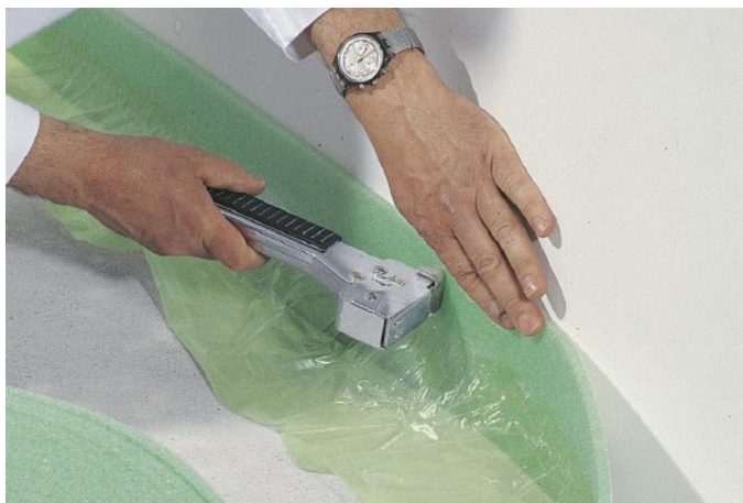
Photo 22: Mise en place des bandes isolantes périphériques Knauf avec une feuille (également au niveau des tuyaux, montants des radiateurs, etc.). Ne pas agraffer à hauteur de la chape.
