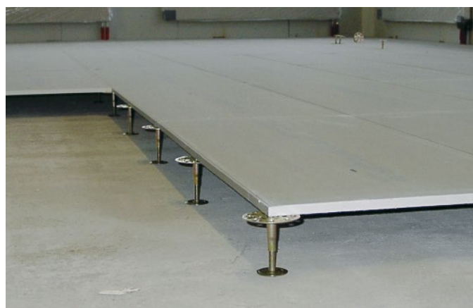
Photo 14: Installation de supports et d'éléments de coffrage
