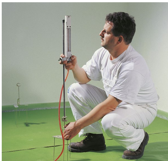
Photo 40: Réglage de la hauteur avec la jauge de niveau PFT
