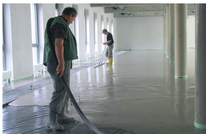
Photo 15: Coulage de la chape fluide sur le plancher creux préparé
