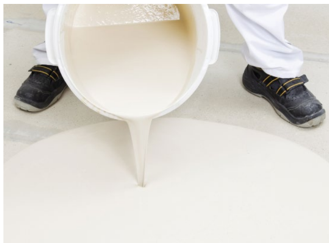
Photo 56: Mise en œuvre manuelle si Knauf N 410
