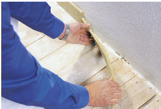
Photo 23: Pose de bandes isolantes périphériques de laine de roche Knauf devant répondre à la protection contre l'incendie
