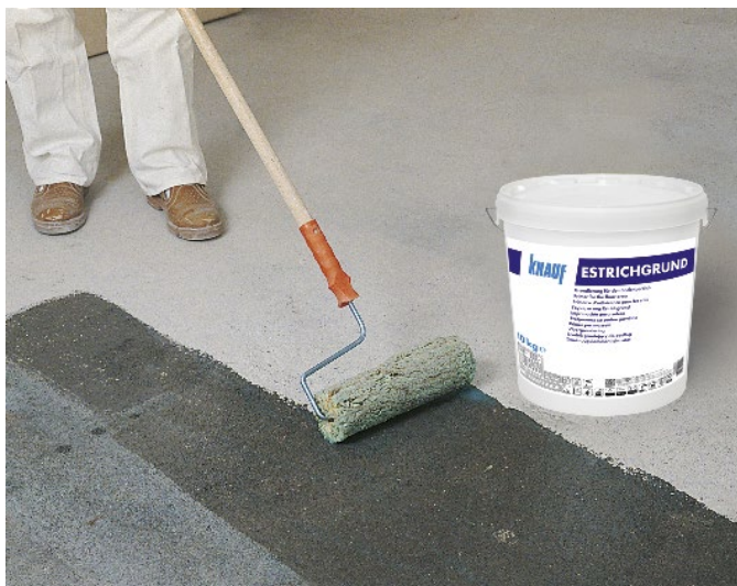
Photo 55: Application de l'apprêt pour chape Knauf
