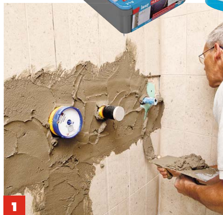
1 Die bei der Installation der Dusch-Armaturen entstandenen Lücken gleichen Sie mit dem Knauf-Reparaturspachtel aus.
