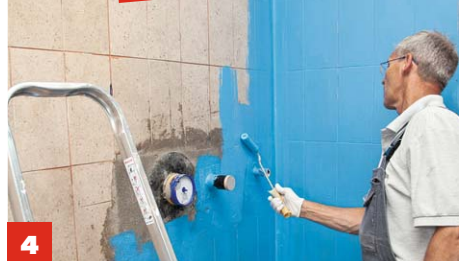
4 Flächendicht in mindestens zwei Schichten mit einer jeweiligen Trocknungszeit von sechs Stunden auf die Fläche streichen.
