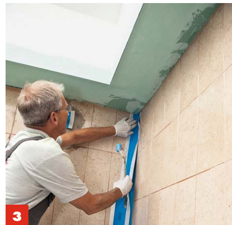
3 Für das Knauf-Flächendichtband Knauf-Flächendicht in die Ecke streichen, Band eindrücken und satt darüberstreichen.
