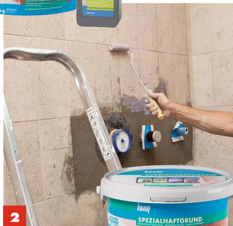
2 Duschbereich abdichten: Knauf-Spezialhaftgrund auf die gereinigten Fliesen und die trockene Spachtelmasse auftragen.
