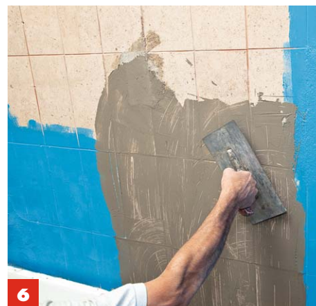
6 Eine sogenannte Kratzspachtelung sorgt für erstklassige Haftung zwischen Fliesenkleber und alter Fliesenfläche.
